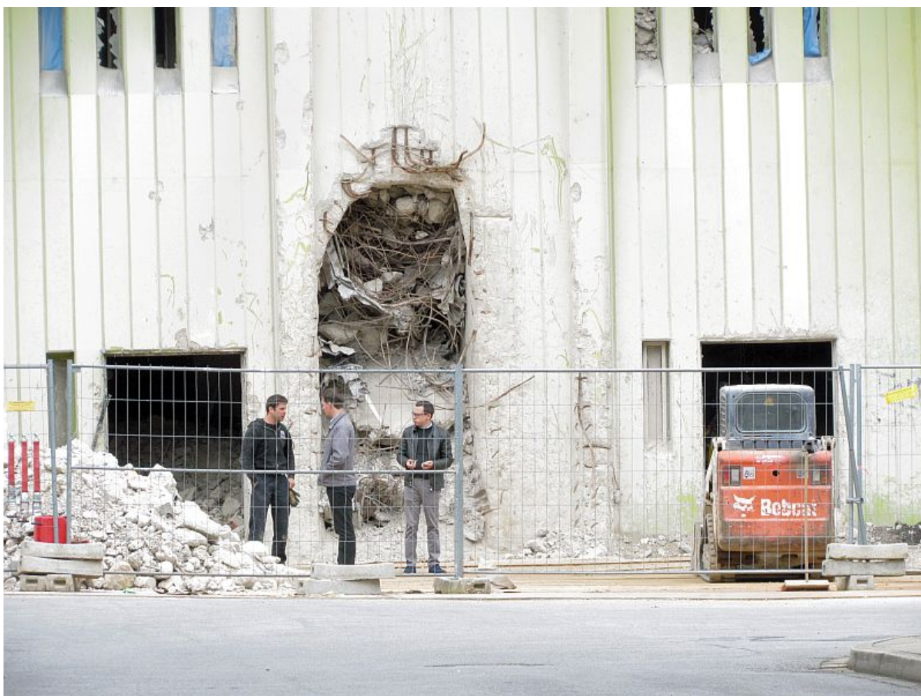
Die Eingänge zum Wohnturm-Stumpf werden frei gelegt.
