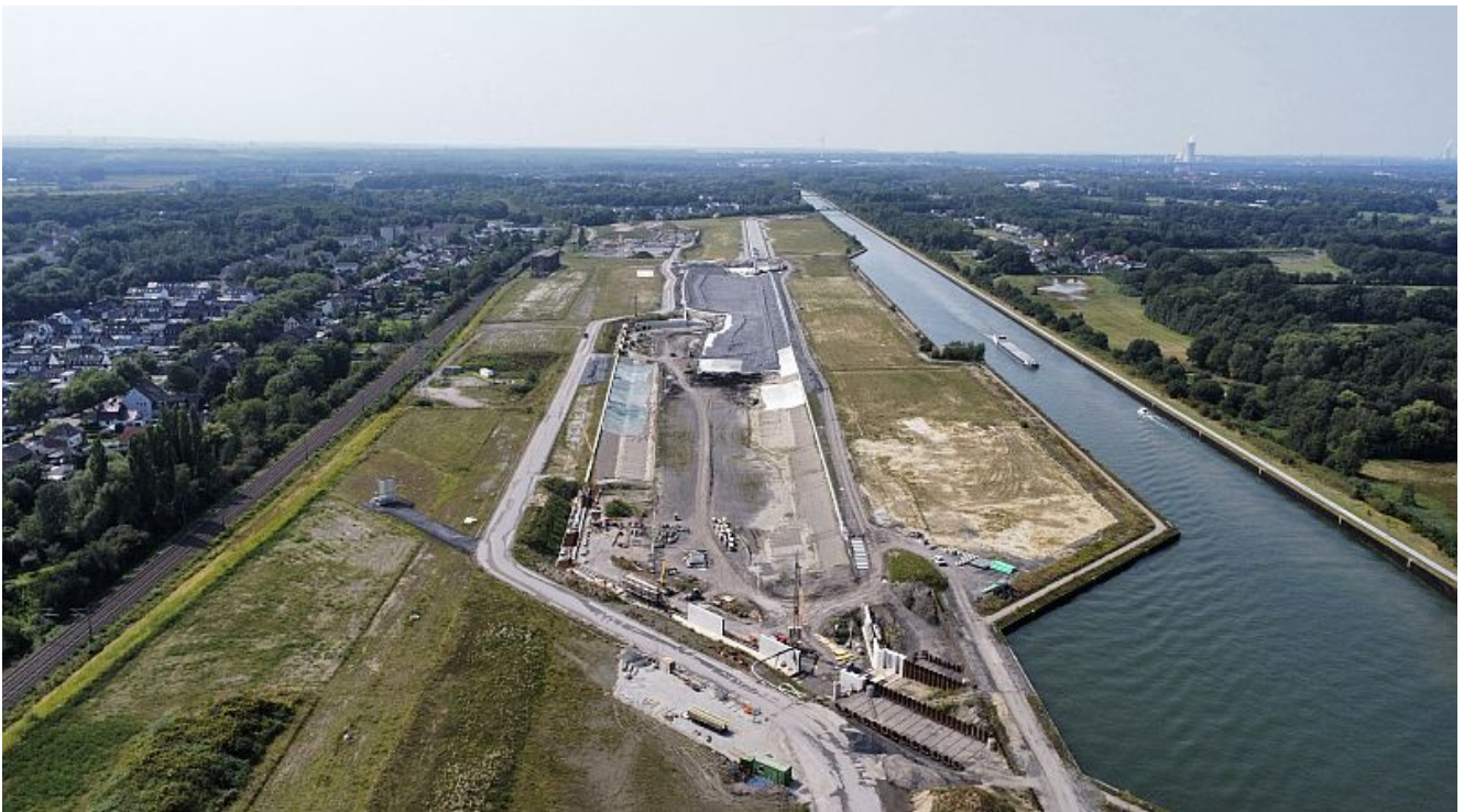
Großbaustelle Wasserstadt Aden.
