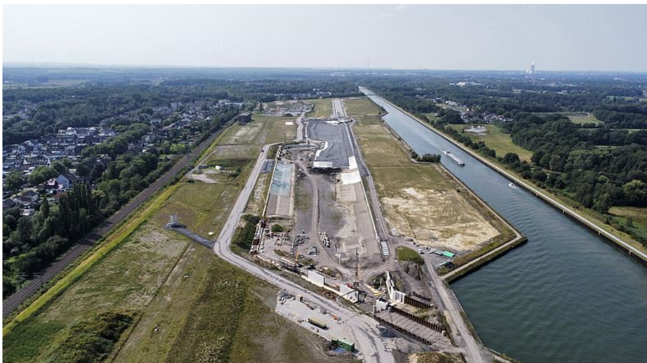
Großbaustelle Wasserstadt Aden.
