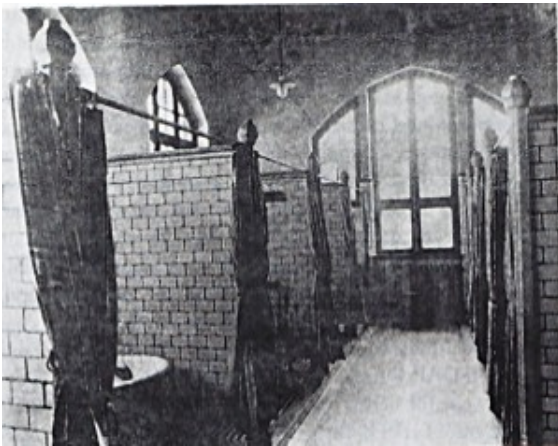
Waschkabinen im Wohlfahrtsgebäude
