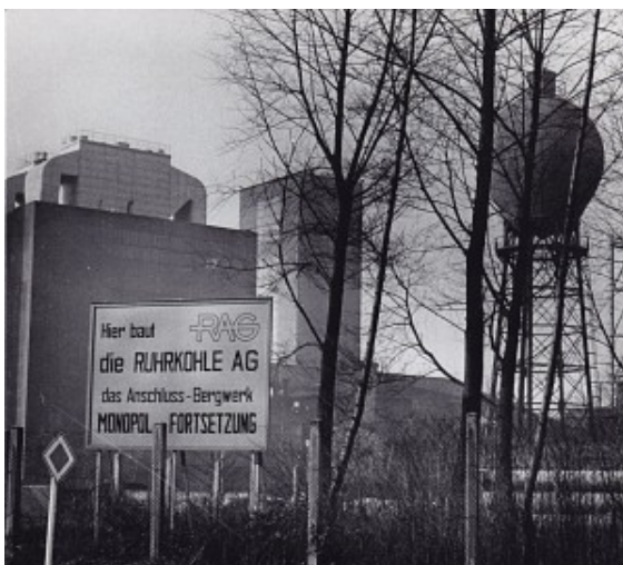
Auf dem Gelände der Zeche
