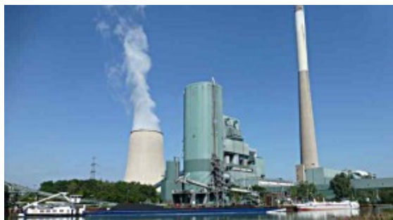
Das Steinkohlekraftwerk in Heil.
