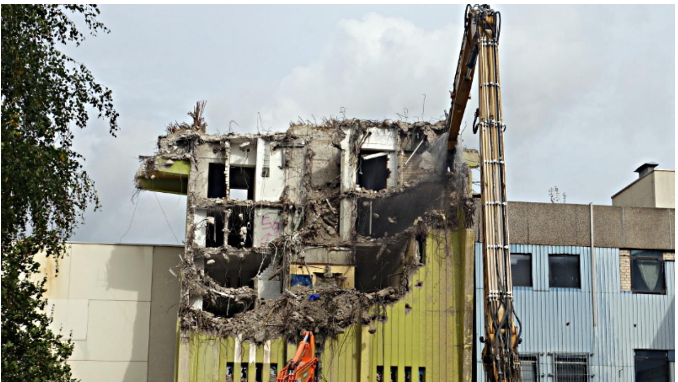
Aktuelles Foto vom Wohnturm-Abriss.
