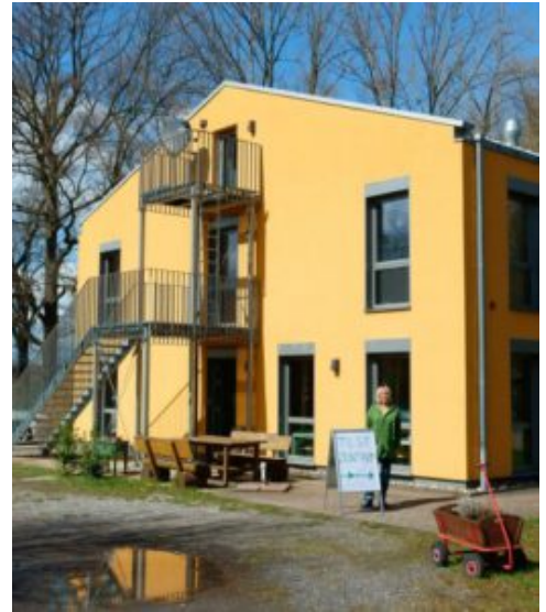
Gästehaus an der Ökologiestation.
