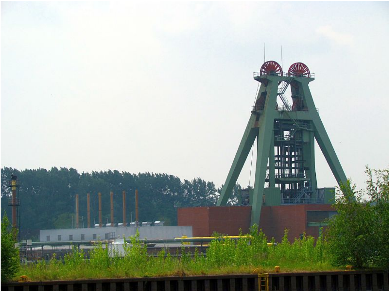
Das Schachtgerüst Haus Aden 2 .
