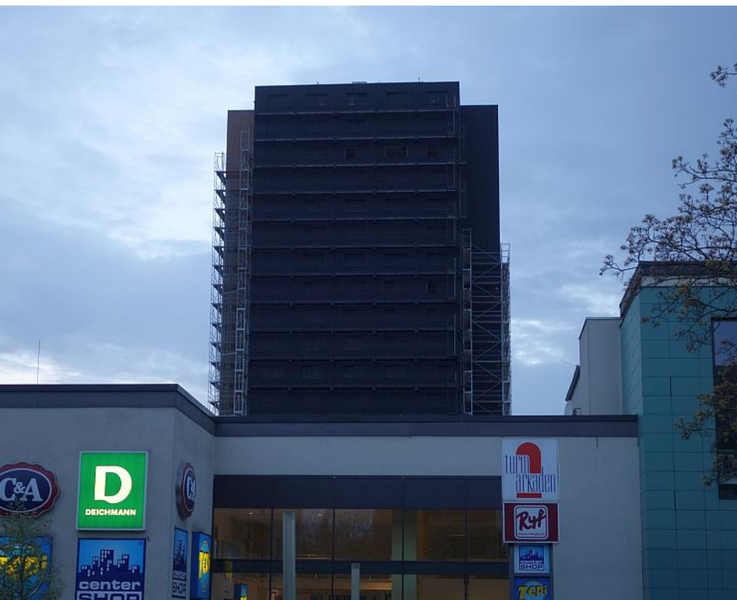
Bergkamener Wohnturm in der Abenddämmerung.
