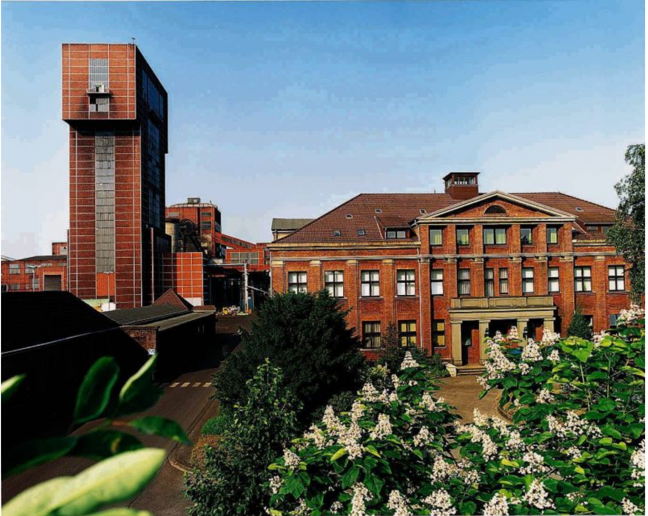
Ehemaliges Bergwerk Ost in Hamm
