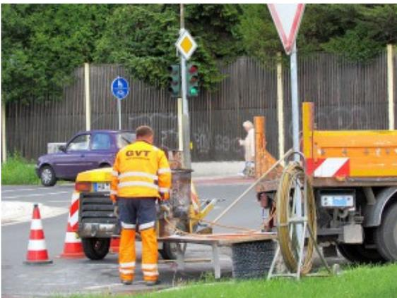
Im Einmündungsbereich der Geschwister-Scholl-Straße in die Landwehrstraße werden Induktionsschleifen eingebaut.
