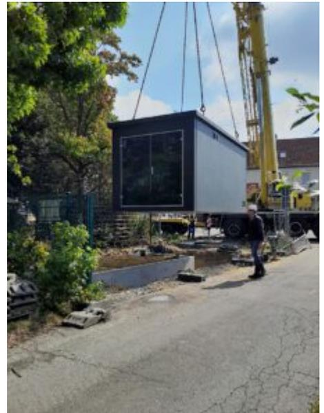
des Schwerlastkrans geleistet werden, als die Station auf das Fundament gehoben wurde. Bis die neue Anlage Ende August in Betrieb genommen werden kann, sind noch einige Arbeiten durchzuführen.
