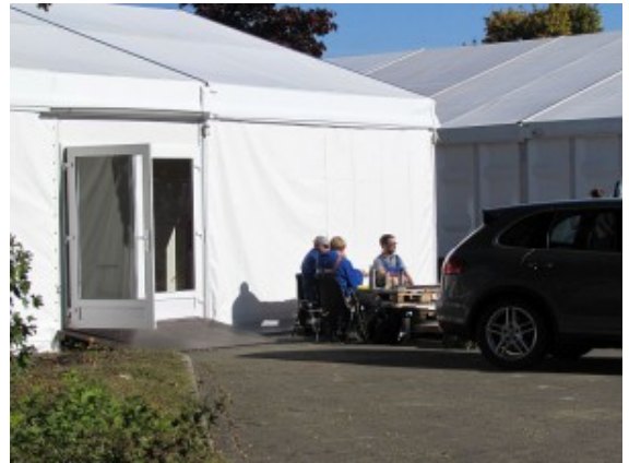
Das Aufnahmezelt von außen.
