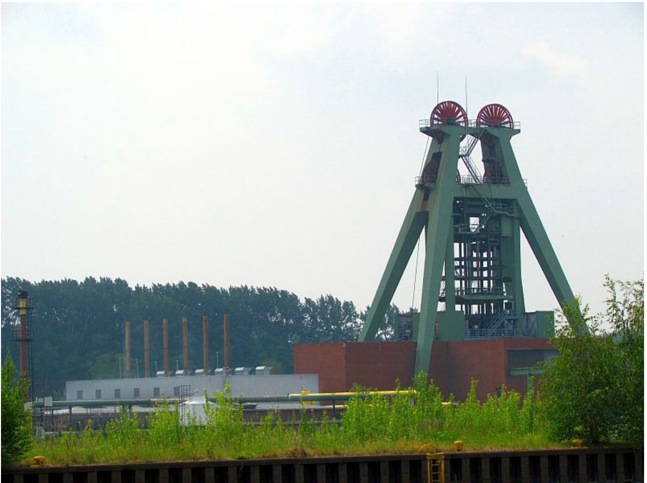
Das Schachtgerüst Haus Aden 2 .
