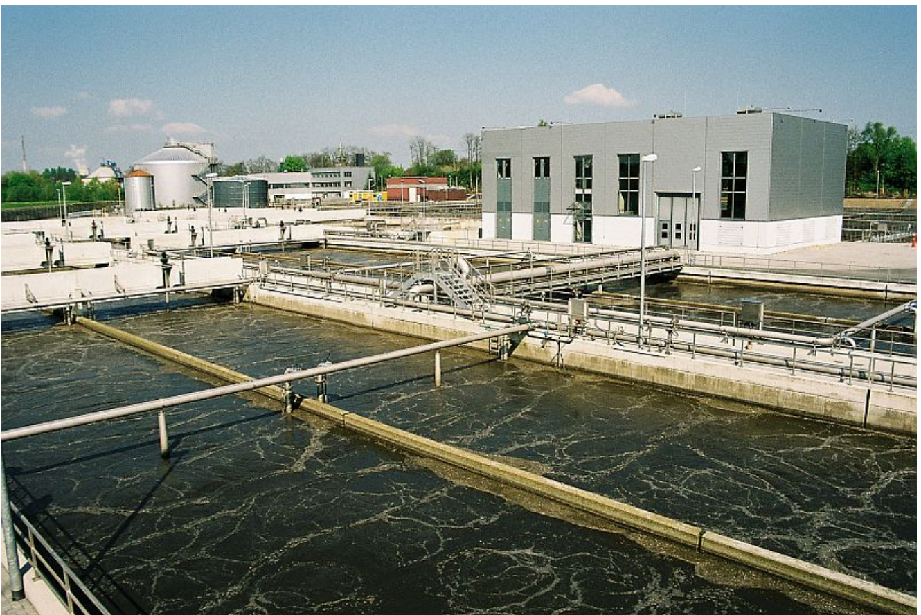
Kläranlage Lünen. Foto: Lippeverband
