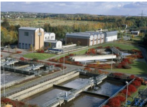
Kläranlage des Lippeverbands in Scharnhorst
