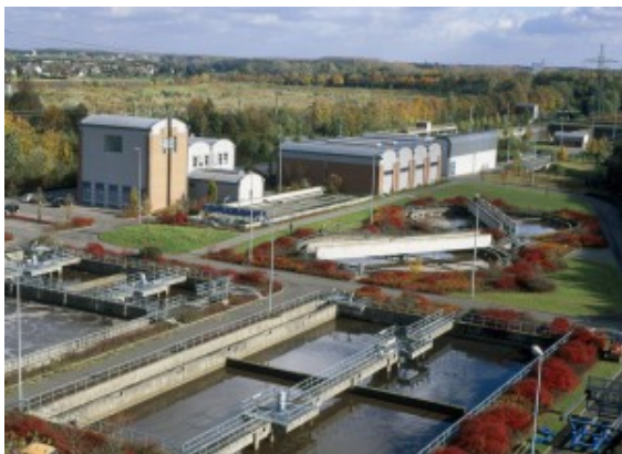
Kläranlage des Lippeverbands in Scharnhorst
