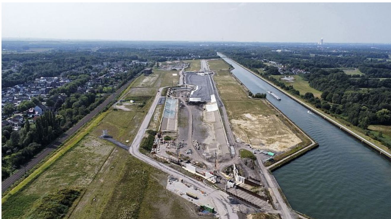
Großbaustelle Wasserstadt Aden.
