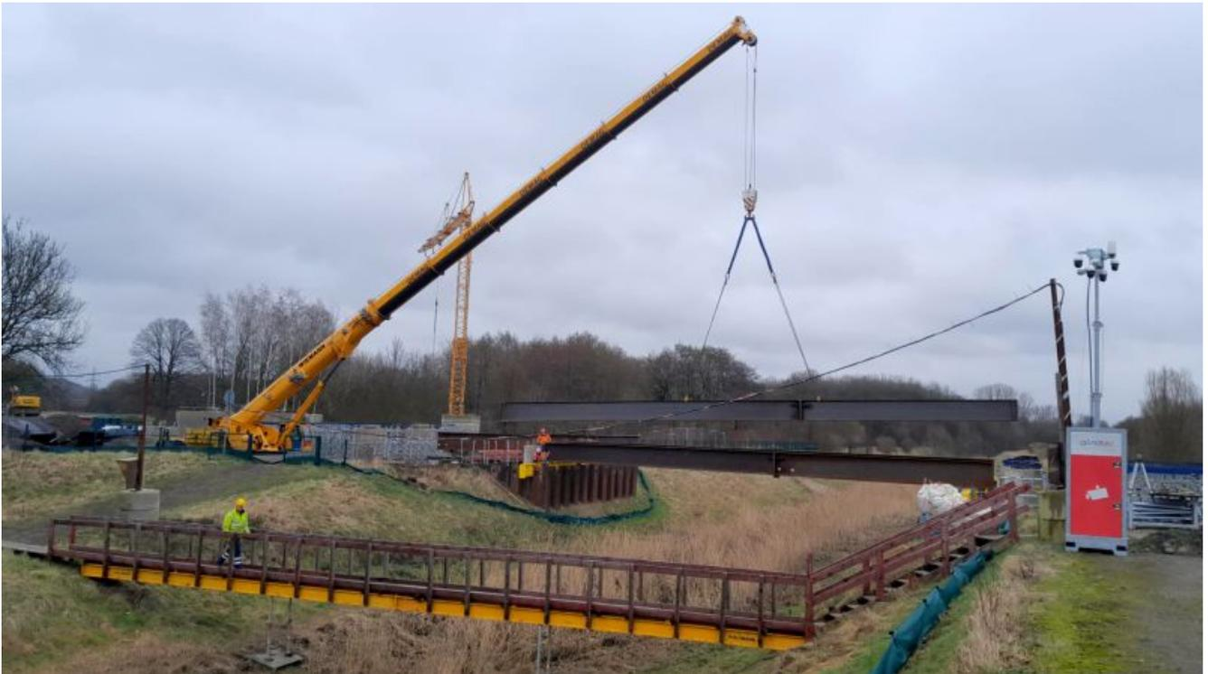
Mit einem 250 Tonnen schweren Autokran wurden die Stahlträger in Position gehoben. Foto: Karl Pollmann GmbH
