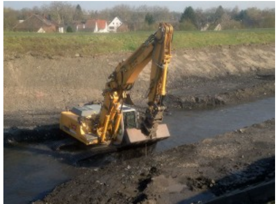
Bagger im Unterlauf der Seseke
