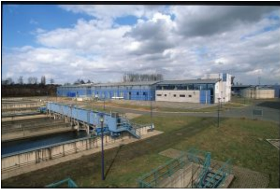
Die Kläranlage (KLG) Kamen-Körnebach. Foto: Lippeverband
