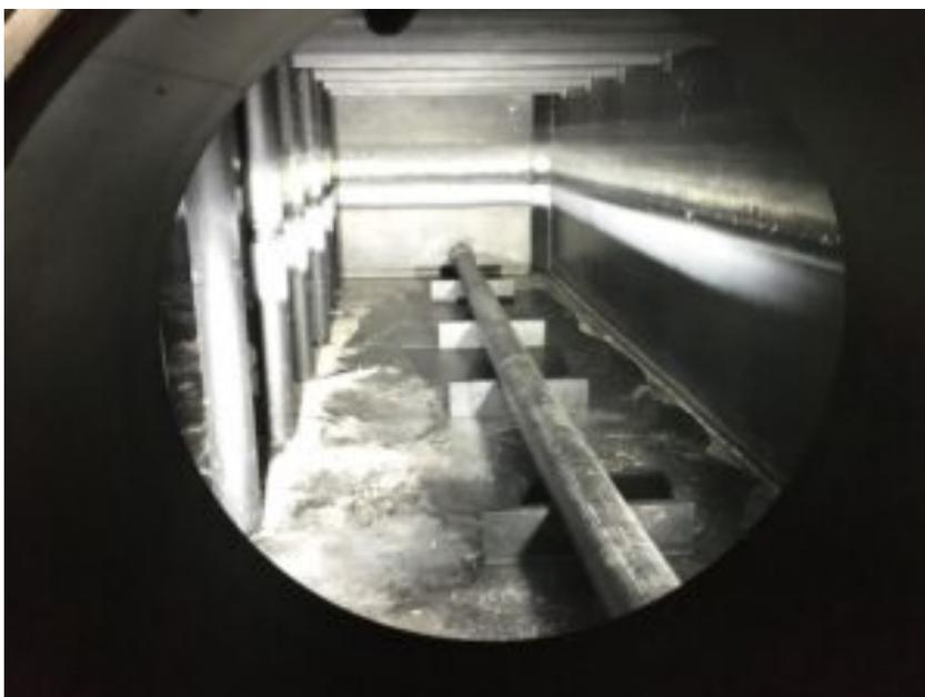
„Blick hinter die Kulissen: Unter den Becken befinden sich die Schallwasserbehälter, die während der Revisionsarbeiten gereinigt und desinfiziert werden.“ Foto: GSW
