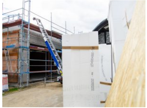
Gerüste am Neubau.
