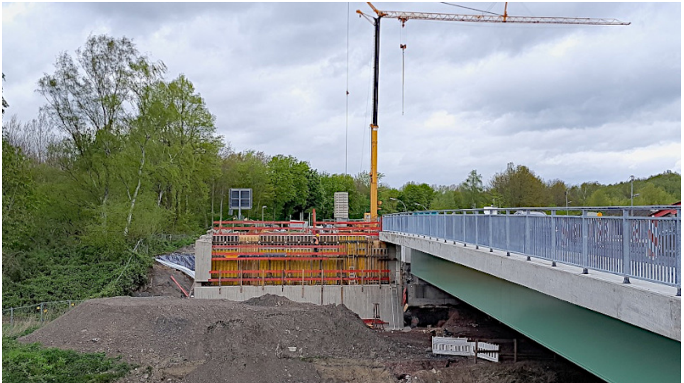
Die neue Lippebrücke vor dem Vershub. Foto: Straßen NRW
