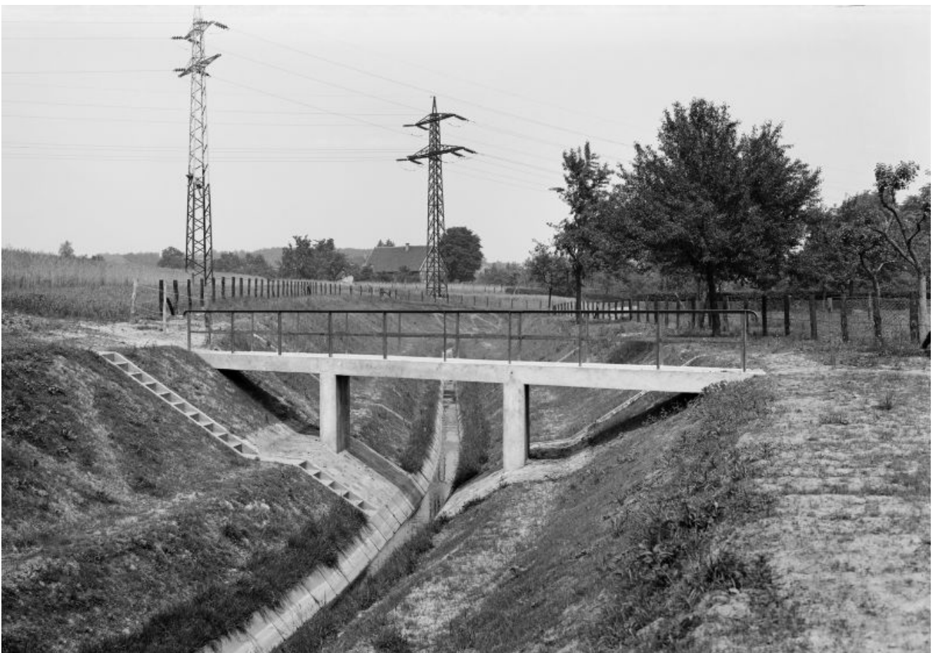
Fußgängerbrücke über dem Kuhbach im Jahr 1937. (Foto: Lippeverband)
