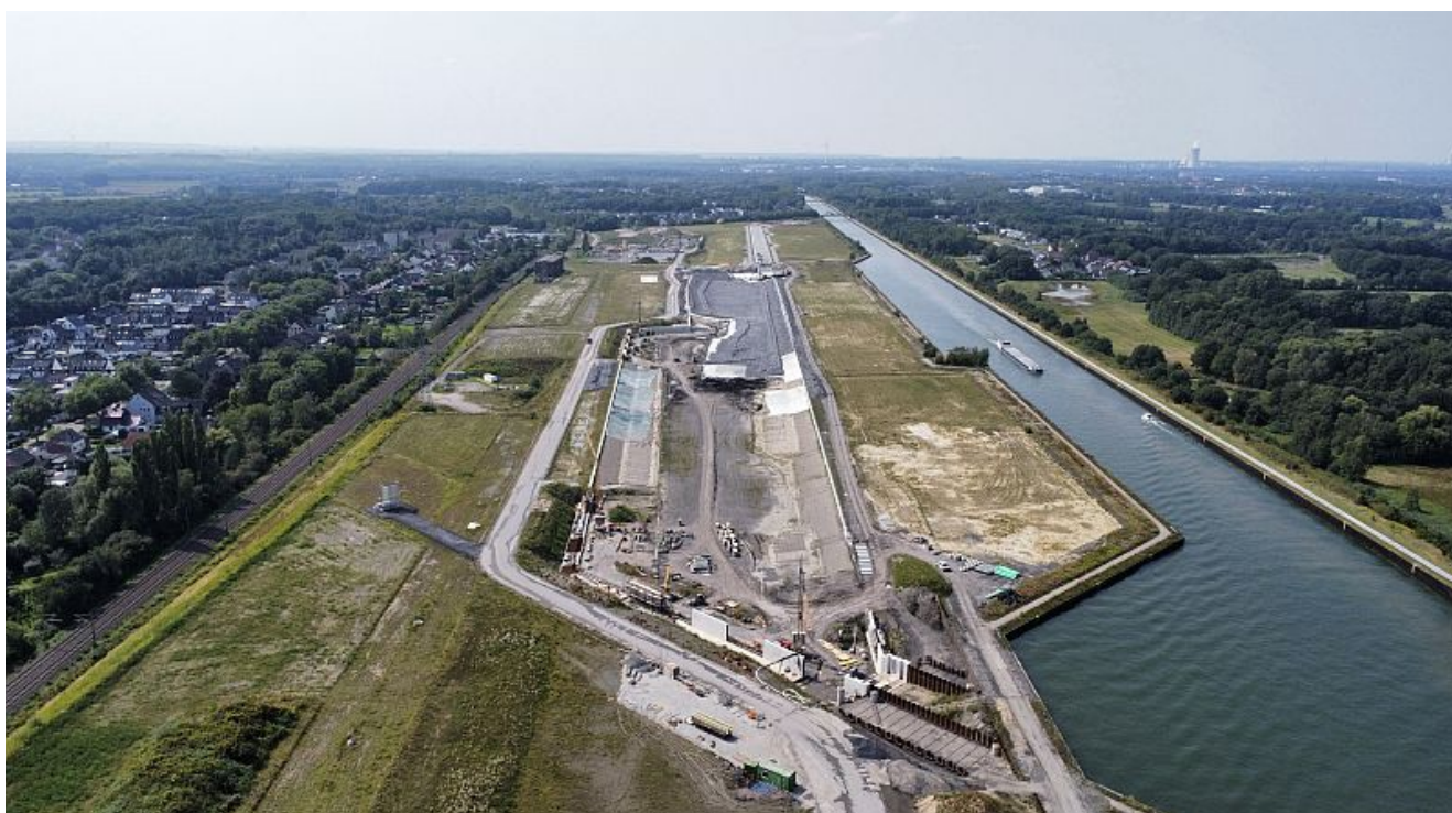
Großbaustelle Wasserstadt Aden.
