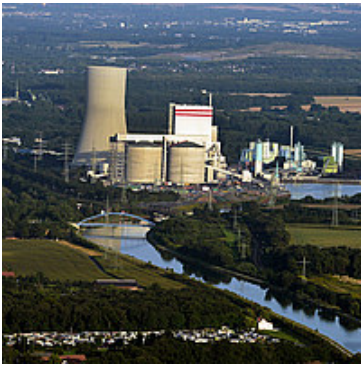
Trianel Kraftwerk Lünen
