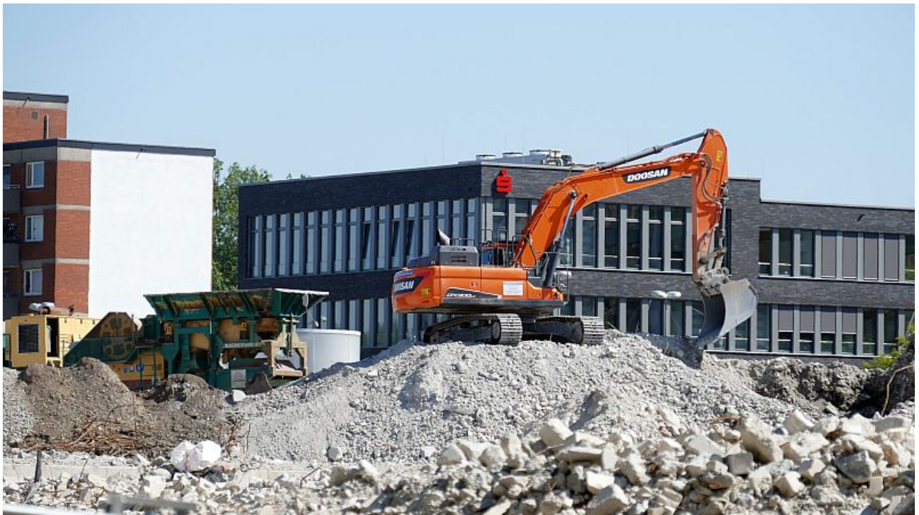
Abrissarbeiten auf dem Gelände der Turmarkaden.
