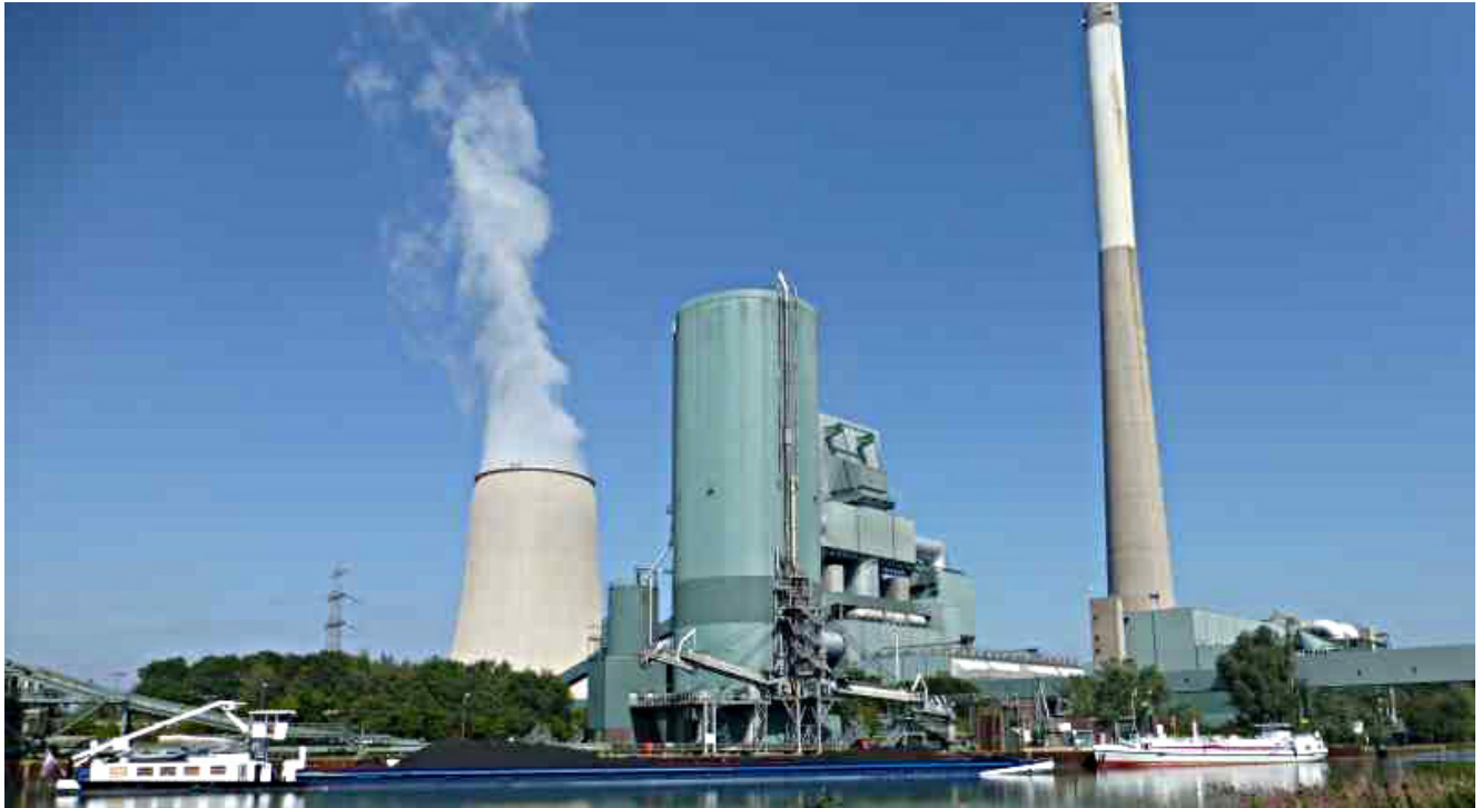
Das Steinkohlekraftwerk in Heil.
