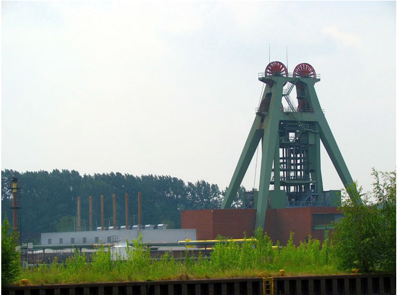
Das Schachtgerüst Haus Aden 2 .
