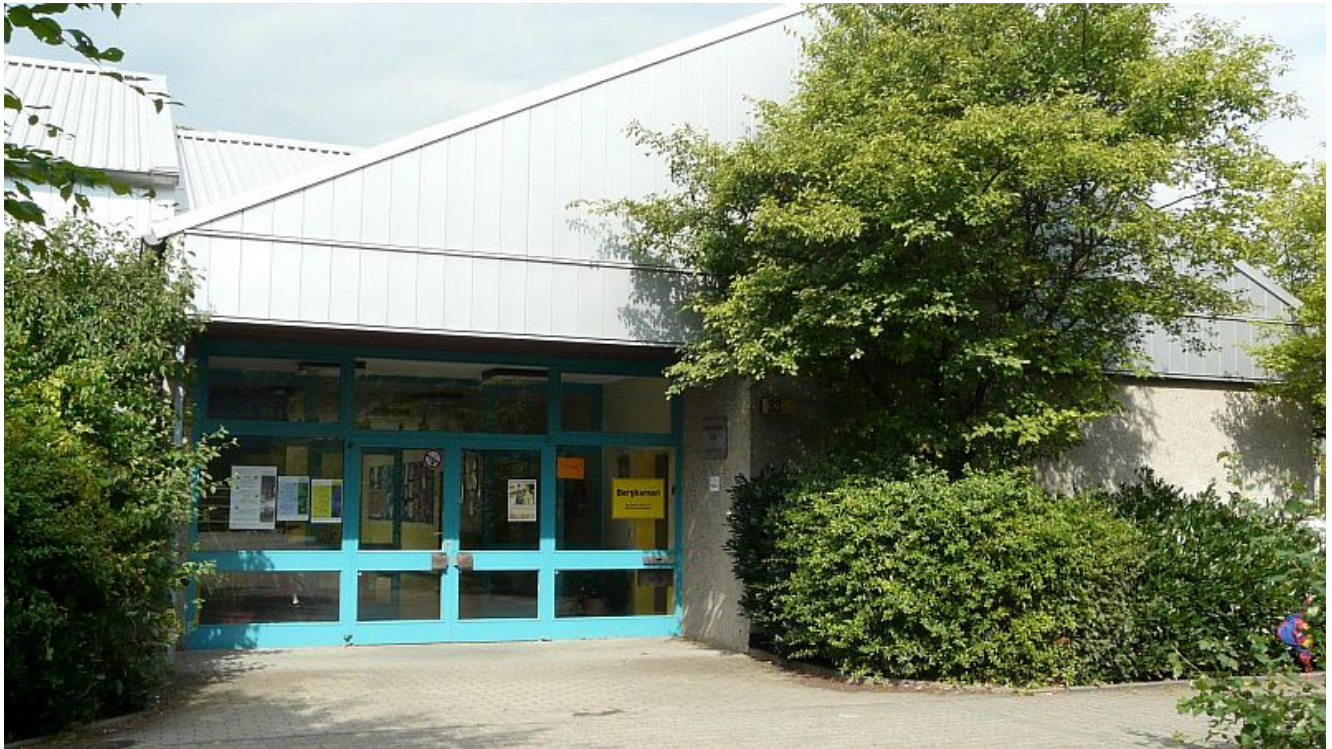
Haupteingang der Gerhart-Hauptmann-Grundschule.
