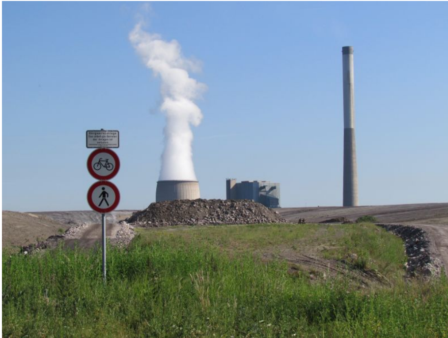
Blick auf die künftige Naturarena und das Kraftwerk Heil.
