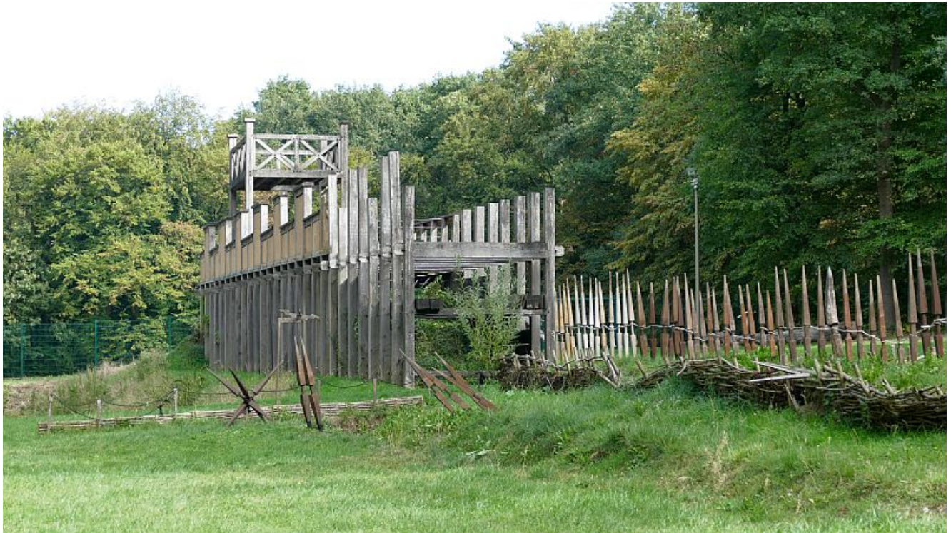
Holz-Erde-Mauer im Römerpark Bergkamen.
