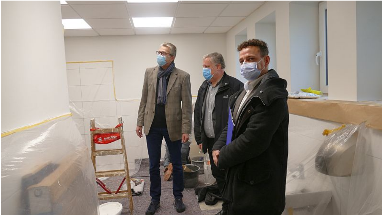
Besichtigung der Baustelle Preinschule.
