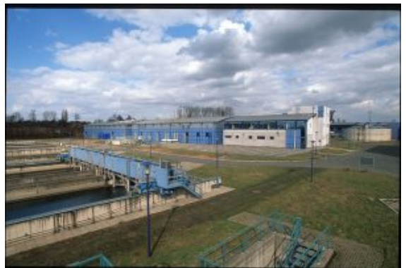
Die Kläranlage (KLG) Kamen-Körnebach.
