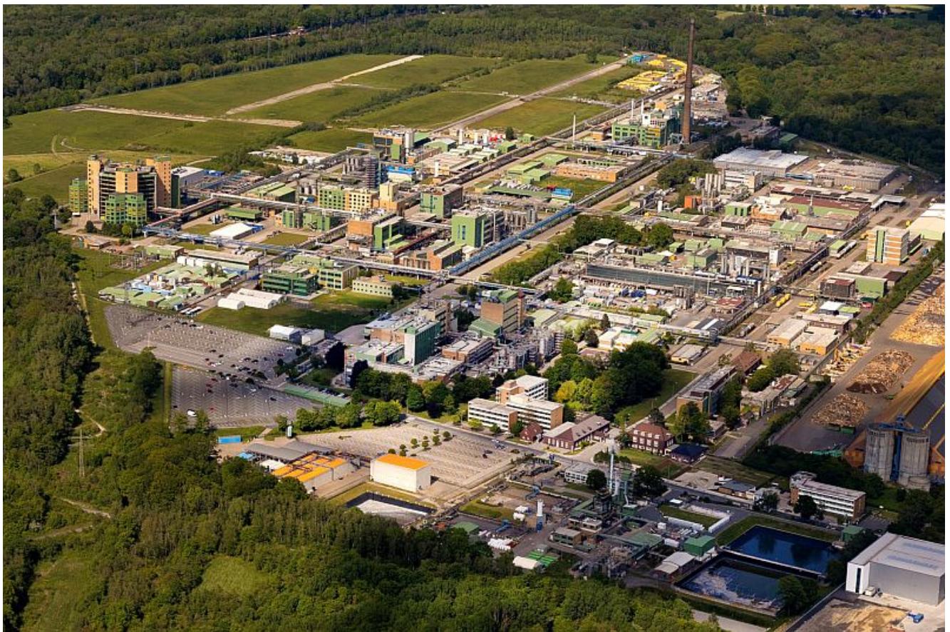
Luftaufnahme des Bayer-Standorts Bergkamen. Foto: Bayer AG
