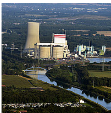
Trianel Kraftwerk Lünen
