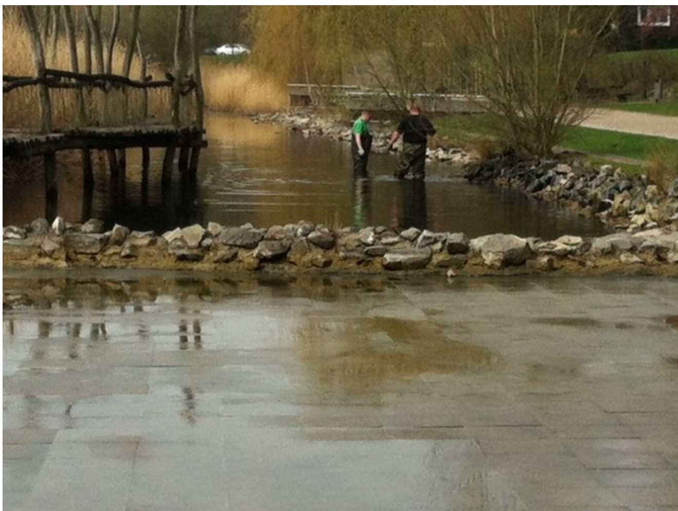
Reinigungsarbeiten im Teich im Wasserpark
