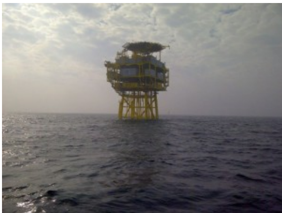
Die Umspannplattform in der Nordsee vor Borkum.
