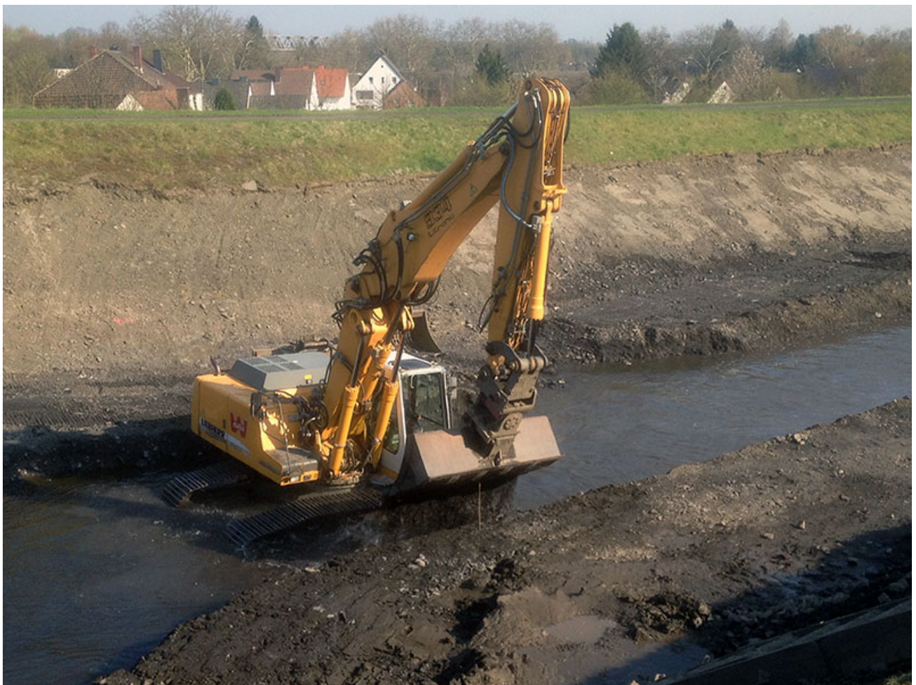
Bagger im Unterlauf der Seseke
