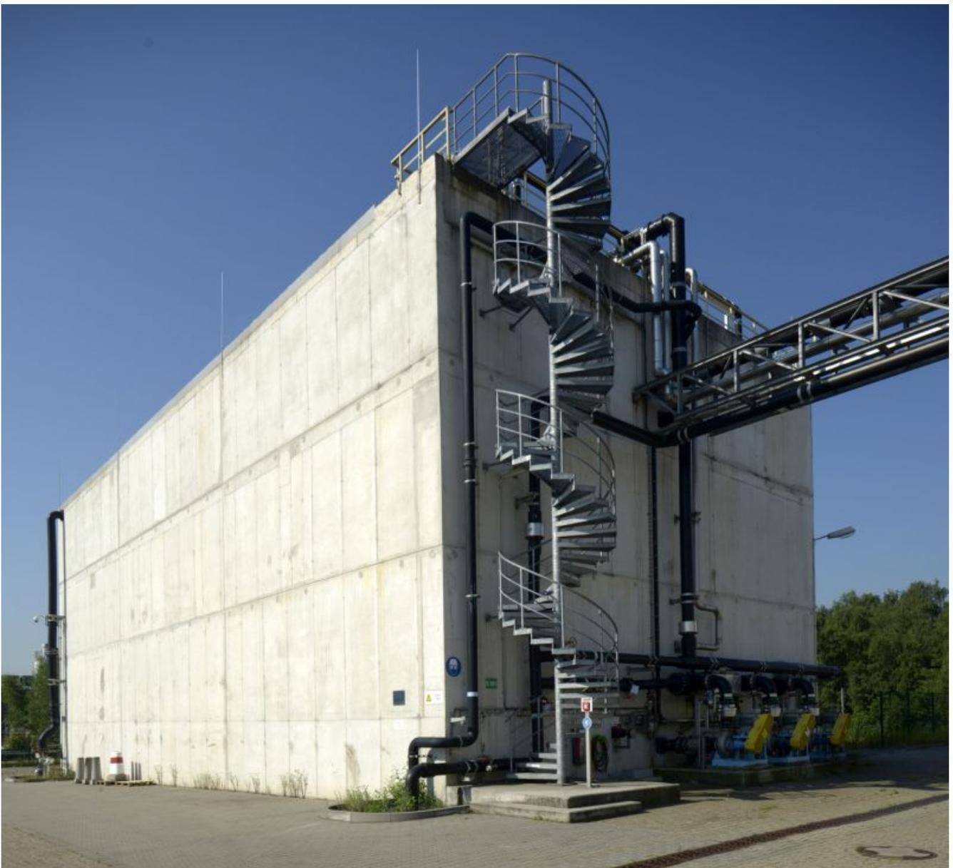
Der Pufferbehälter der Kläranlage ist mehr als 27 m lang, 11 m
