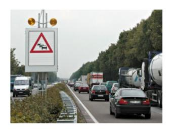
Die Verkehrsführung wird jetzt in die Phase 5 umgelegt. Hier läuft der Verkehr für sechs Wochen in jeder Fahrtrichtung in drei eingeengten Fahrstreifen nach außen gedrückt. Hierdurch ergibt sich ein Baufeld in der Autobahnmitte. Gesperrt ist
