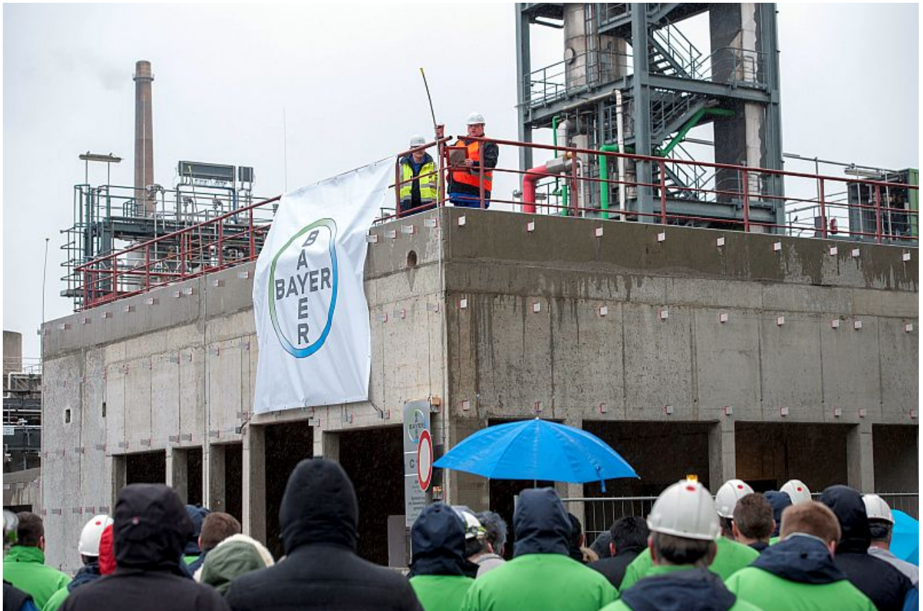
Sturmfest: Genau wie der Rohbau des Labor- und Wartengebäudes trotzten die Teilnehmer des Richtfestes dem schlechten Wetter. Foto: Bayer AG
