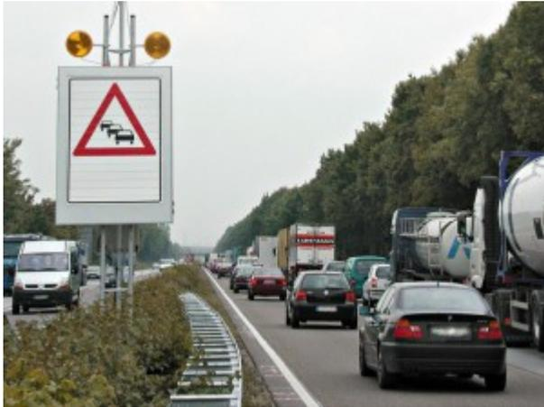
Die Verkehrsführung wird jetzt in die Phase 5 umgelegt. Hier läuft der Verkehr für sechs Wochen in jeder Fahrtrichtung in drei eingengten Fahrstreifen nach außen gedrückt. Hierdurch ergibt sich ein Baufeld in der Autobahnmitte. Gesperrt ist jeweils der zweite Überholstreifen in jeder Richtung. In dieser Bauphase montiert Straßen.NRW in Fahrtrichtung Oberhausen im Mittelstreifen auf 9,3 Kilometer neue Schutzplanken.
