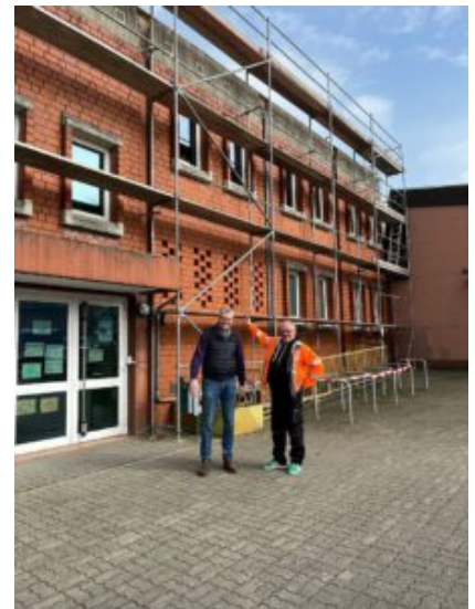
Bernd Schäfer (l.) mit dem Leiter des Baubetriebshofs Stephan Polplatz am Baugerüst.
