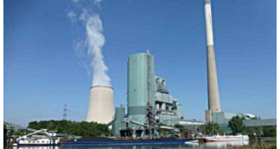
Das Steinkohlekraftwerk in Heil.
