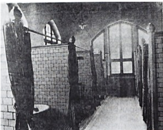
Waschkabinen im Wohlfahrtsgebäude
