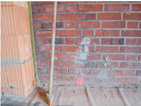
Alte und neue Mauern direkt nebeneinander.
