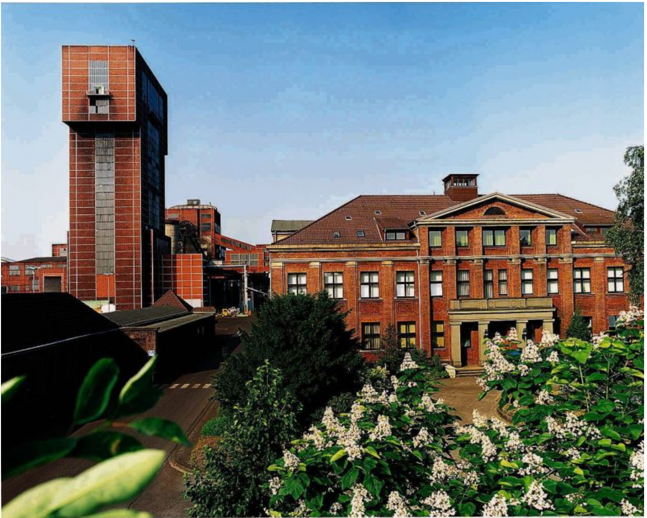
Ehemaliges Bergwerk Ost in Hamm
