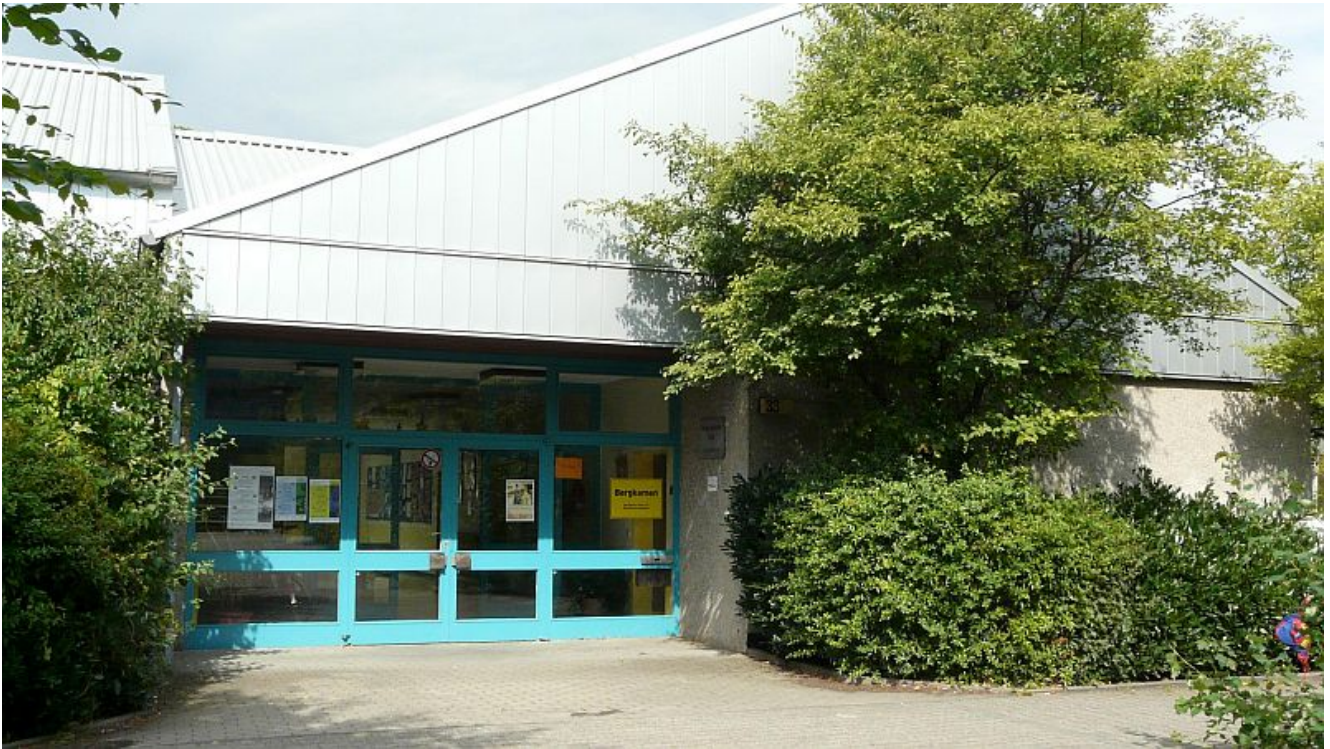
Haupteingang der Gerhart-Hauptmann-Grundschule.
