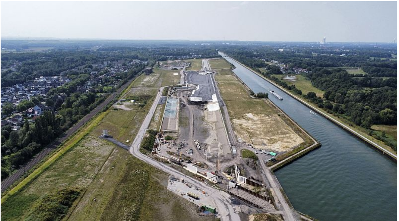
Großbaustelle Wasserstadt Aden.
