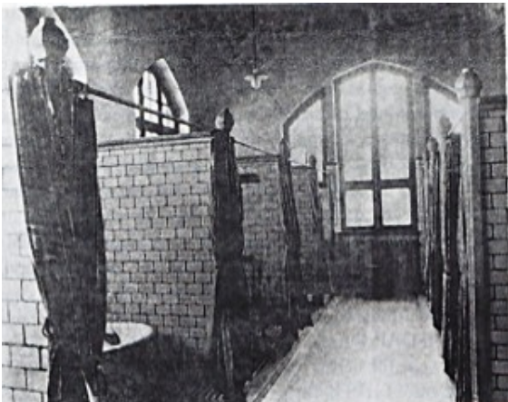
Waschkabinen im Wohlfahrtsgebäude
