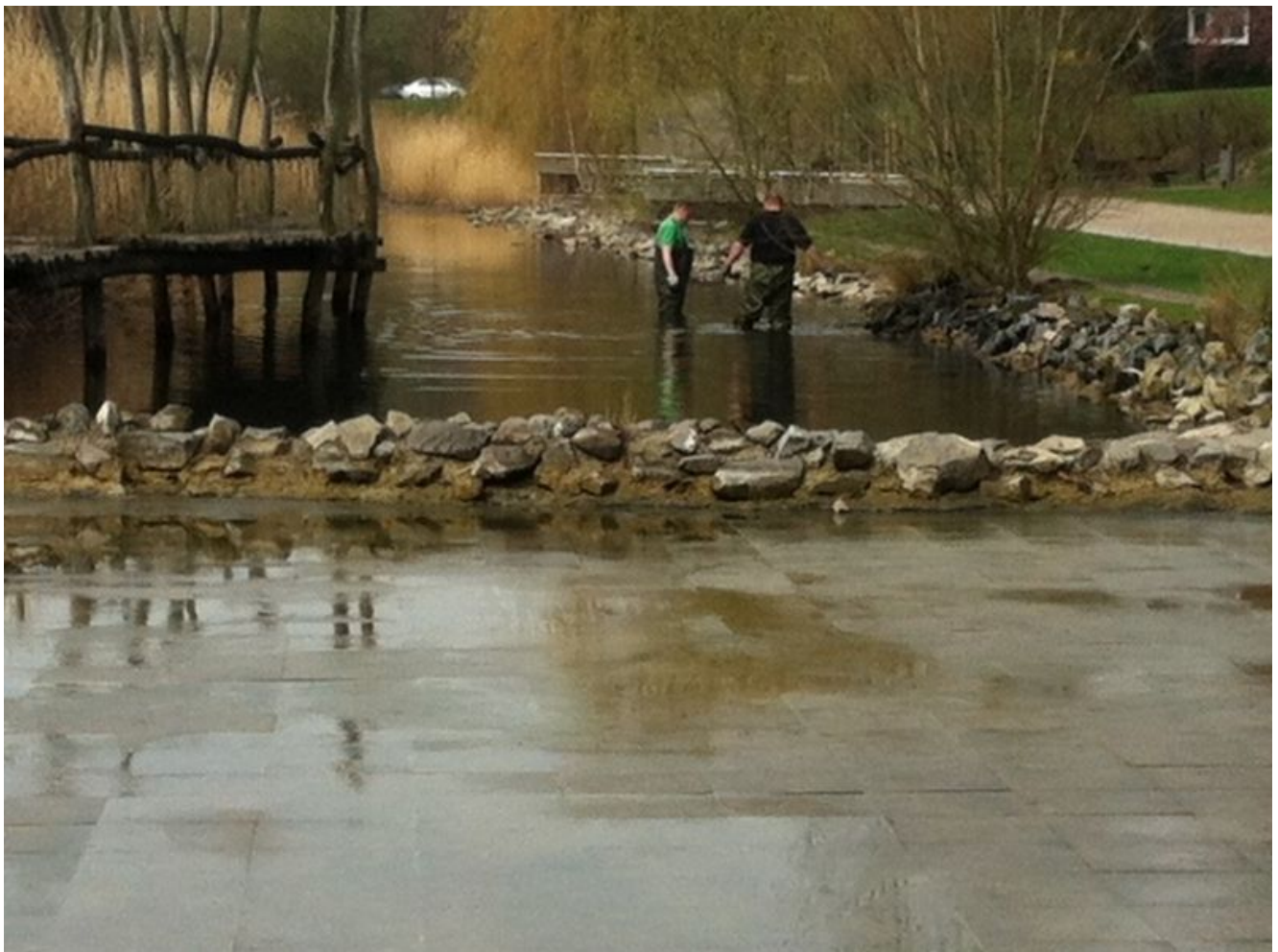
Reinigungsarbeiten im Teich im Wasserpark
